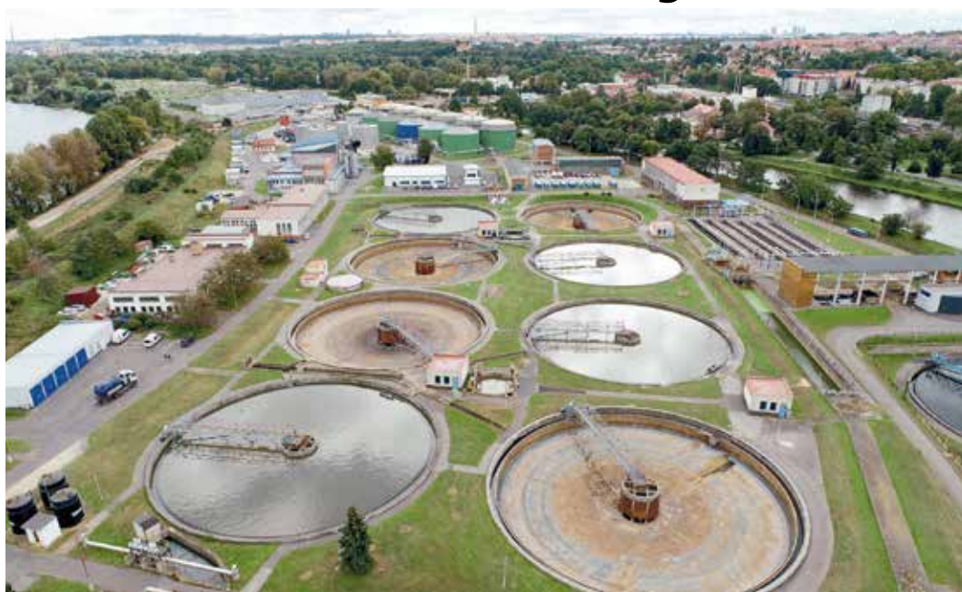
▲ Stávající čistírna byla plně uvedena do provozu v roce 1965
