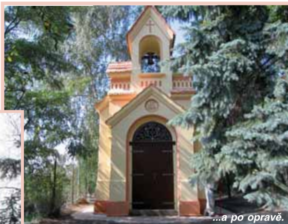
...a po opravě.
