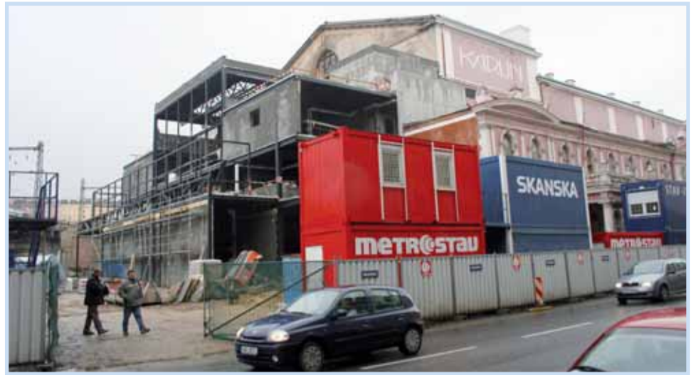
V únoru byla v Karlíně vybourána zadní strana divadla. Dnes se vyzdívá zavázeční tunel, který bude navazovat na jeviště. Hudební divadlo se po rekonstrukci poprvé v historii dočká i takzvaného zadního jeviště.
