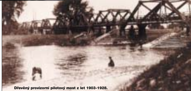
Dřevěný provizorní pilotový most z let 1903-1928.
