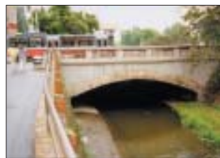
Libeňský mostek přes Rokytku.
