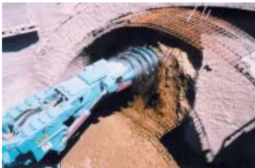
V Trojské ulici byla zahájena ražba tunelu prodloužené trasy metra C.
