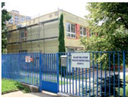
Budova školky získává novou kvalitní fasádu
