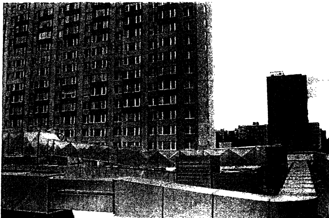
POHLED OD SUCHÝCH CHLADIČŮ K OBJEKTU OLŠŤANSKÁ 607/1
