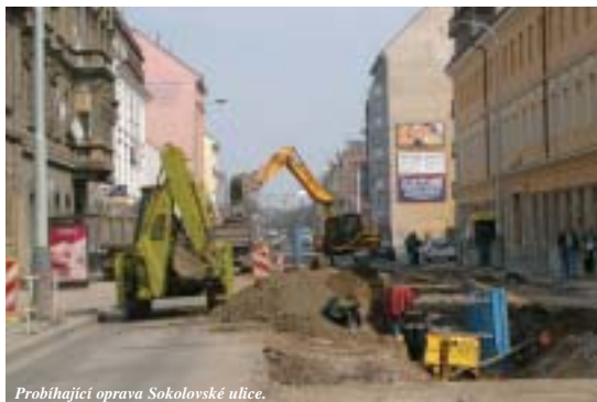
Probíhající oprava Sokolovské ulice.
