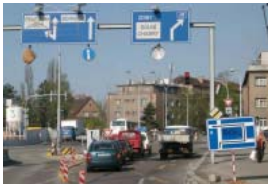
Stavba nové stanice metra trasy C na Kobyliském náměstí finišuje.
