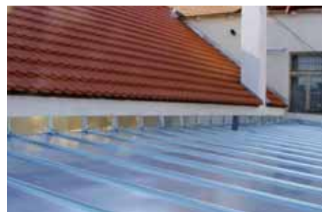
Střecha divadla před a po rekonstrukci
