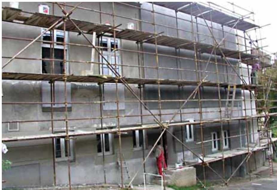
Budova získala i novou fasádu. Na fotografii je před nástřikem
