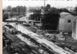
Palmovka stavba metra „B“.
